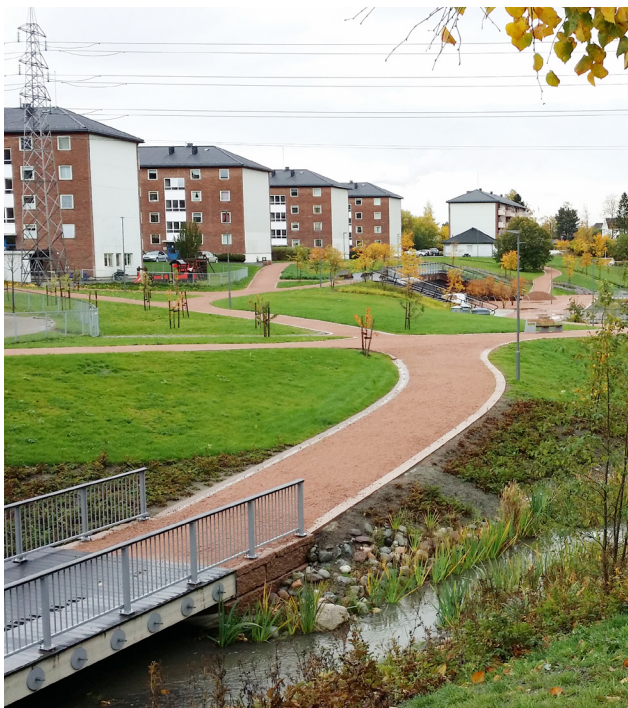
Dagvattenanläggning i bostadsområde som kan fungera som översvämningsyta vid extrema regn, Oslo. Foto: Sweco
