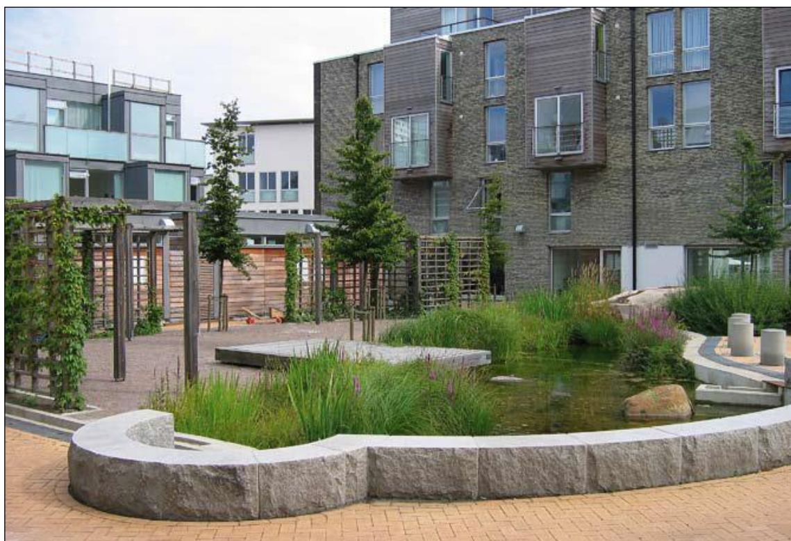
Bild 30: Flödesdämpning och lokalt ombändertagande av dagvatten. Foto: Veg Tech AB
